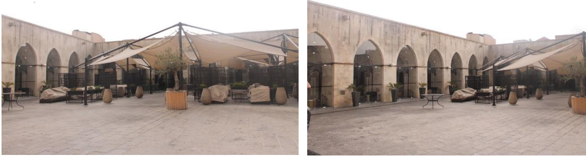
Şekil 3.4. Hışva han yapısında revak
