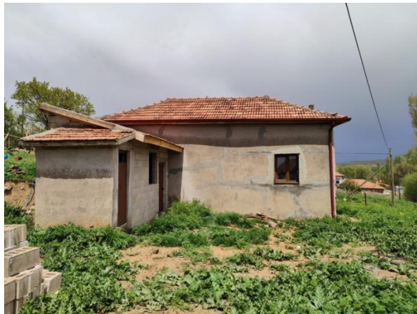
Resim 5. Kuyumcu Ali Usta Odası Dış Cephe Görünümü (Coşgun, 2022)
