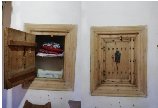
Resim 13. Duvarda yer alan dolap örneği (Özgün).
