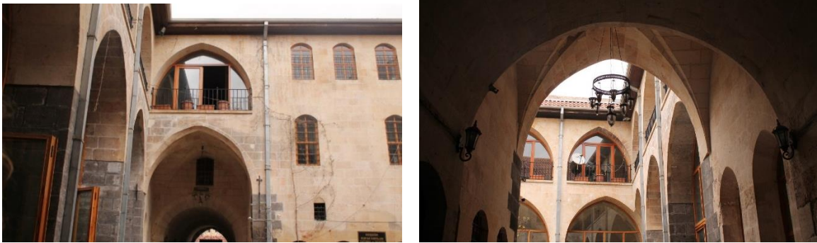
Şekil 3.5. Gümrük Han yapısında revak
