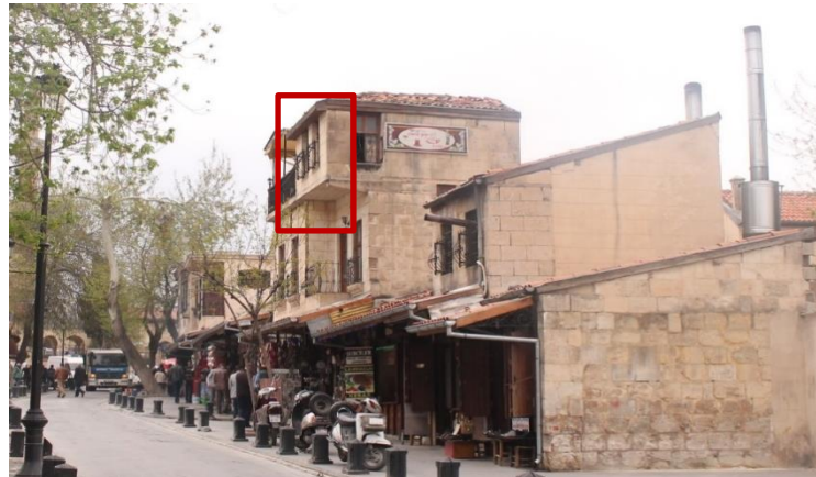
Şekil 3.3. Geleneksel Gaziantep yapılarında pencere üzerinde güneş kontrolünü sağlayan çıkmalar
