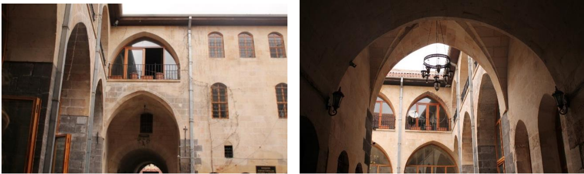
Şekil 3.5. Gümrük Han yapısında revak
