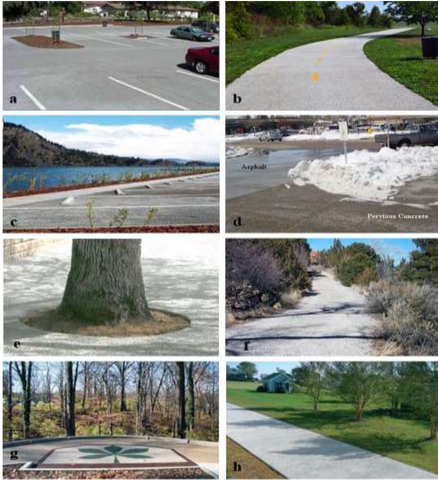
Şekil 1. Geçirgen betonun kullanım alanları: (a), (c), (d) otoparklar; (b), (f) trafiğin yükünün az olduğu ulaşım yolları; (e), (g), (h) yürüyüş yolları ( https://www.perviouspavement.org ; Türkiye Hazır Beton Birliği, 2018)
